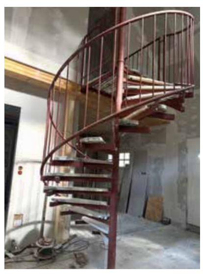
Im Hüsken entsteht ein Quartier mit Küche, Bad und Gemeinschaftsräumen für Handwerker auf der Walz. Durchgeführt wurden die Arbeiten von Holzbau Nienhaus & Hemker.
